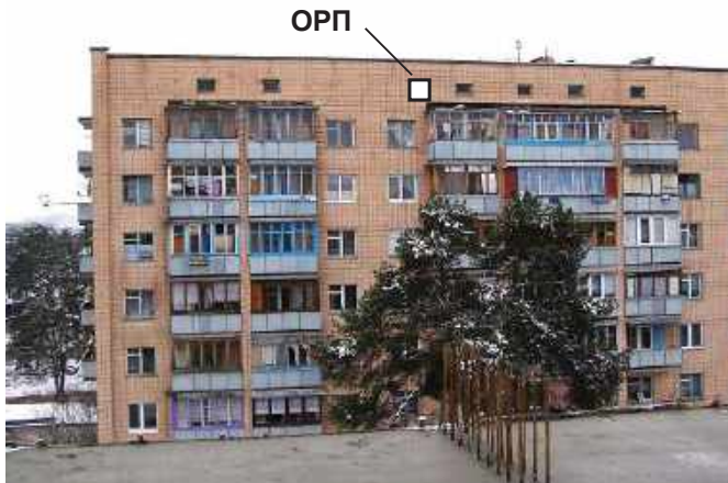
Рисунок 7 — Розташування орієнтирного пункту (ОРП) у вигляді плівкового відбивача на фасаді будинку
