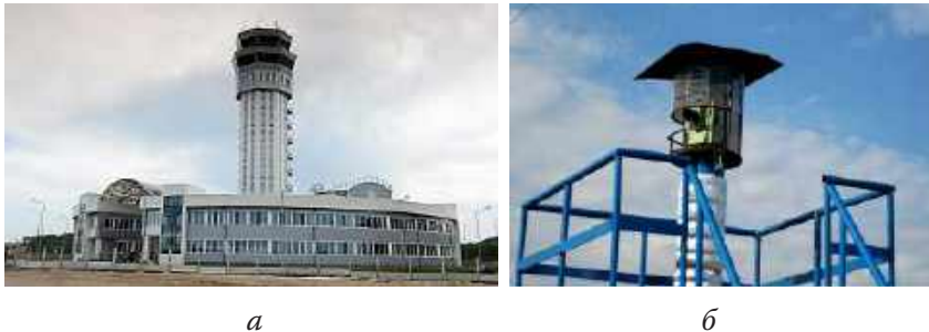
Рисунок 14 — Спостереження за креном та деформаціями споруд аеропорту: а — КДП аеропорту; б — вежа для спостереження з електронним тахеометром в середині
