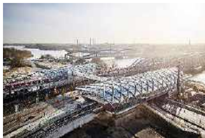
Рисунок 23 — Станція S-Bahn і U-Bahn Elbbrücken. Гамбург, Німеччина, 2019
